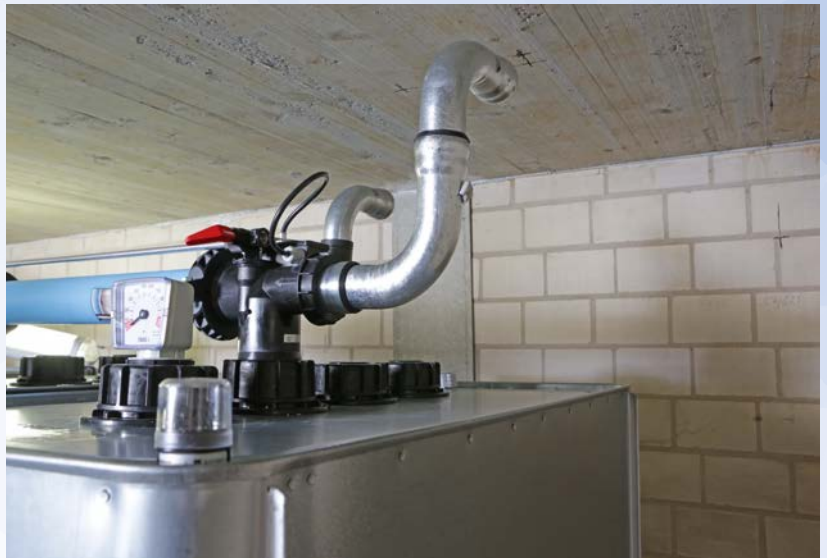
Die bauseitige Füllleitung wird durch Schellen gesichert.
